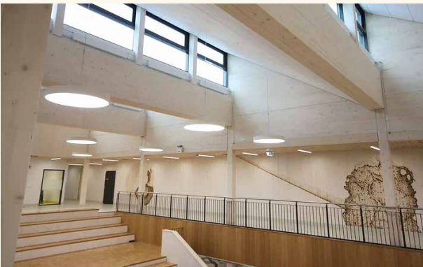
Tynne interiørplater i gran KLT/massivtre med brannimpregnering levert av Moelven Wood Prosjekt.
